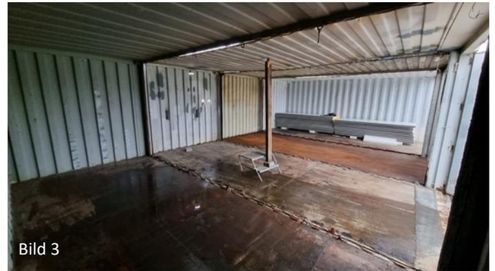
Im nächsten Schritt werden die Containerdächer stabilisiert und es kann der Innenausbau geplant und begonnen werden. Gleichzeitig werden die Arbeiten für das Dach gestartet. Wenn das Dach und die seitliche Eingangstür montiert sind, kann auch die restliche Außenisolierung angebracht werden.
